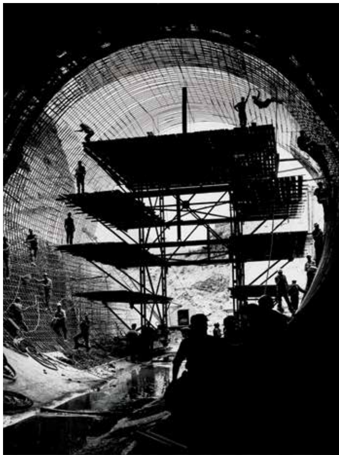
Σήραγγα εκτροπής. Αχελώος, 1960
