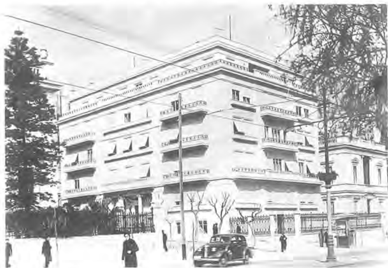
Εικ. 3: Η πολυκατοικία, που κτίστηκε από τον αρχιτέκτονα Κωνστ. Β. Σγούτα στα 1936-1938, στη θέση του προηγούμενου μεγάρου.
